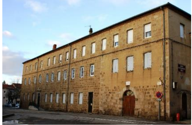
Fachada del colegio. A la izquierda, la entrada principal, más pequeña que la entrada de la antigua capilla de San Luis, en primer plano.
