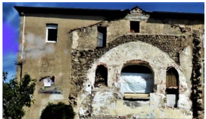
Vanos del convento que daban a la capilla de 1854. Pasaje del románico al gótico en las pequeñas vidrieras.
